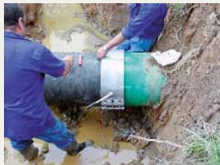
■ Reparatur einer GFK-Leitung mit einem Rohrstück aus Gusseisen mit unterschiedlichen Aussendurchmessern.
