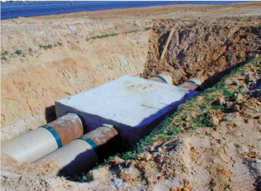
■ Verbindung von GFK- und Stahlrohr mit unterschiedlichen Aussendurchmessern bei den Zu- und Abläufen einer Verteilkammer.
