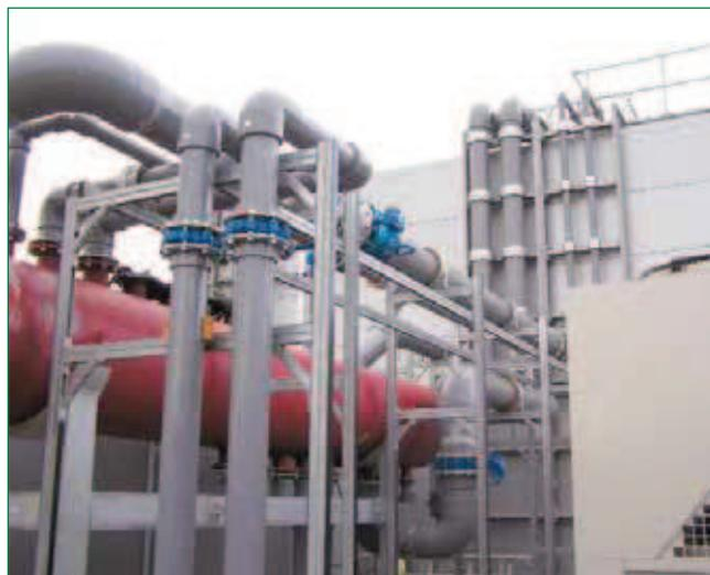
Bild 3: Kühlwasserversorgung für Computerraum aus ABS
