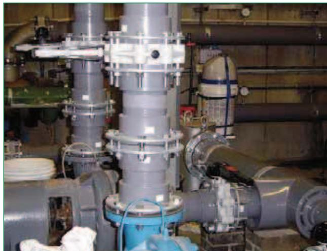
Bild 1: Pumpenverrohrung aus ABS
