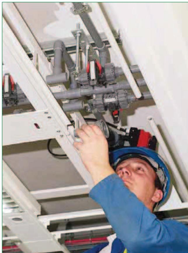
Bild 7: Klimaanlageverrohrung mit ABS
