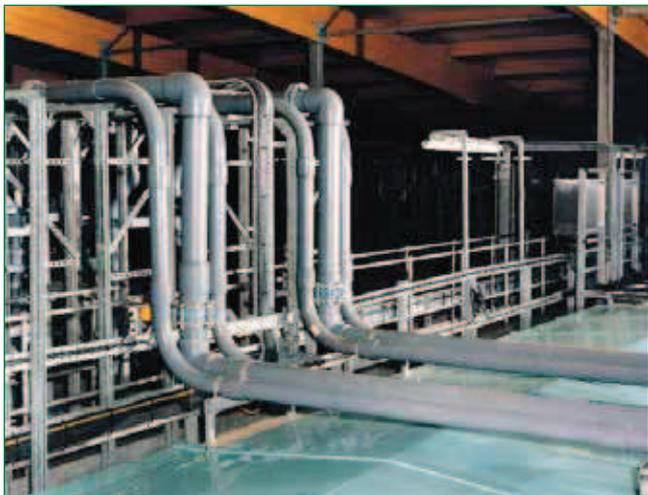
Bild 2: Wasseraufbereitungsanlage mit ABS-Rohrsystem
